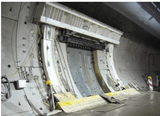
Abbildung 36 Stahlrahmenkonstruktion Katzenbergtunnel
