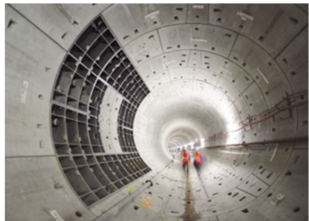
Abbildung 37 Stahl-tübbingung als Teil der Querschlagabfangung
